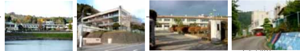
【校舎】 校舎は現在の加茂中学校を改修して対応することになっている。教室棟（3階建）の1階部分を図書室等の特別教室、2階部分を小生用
